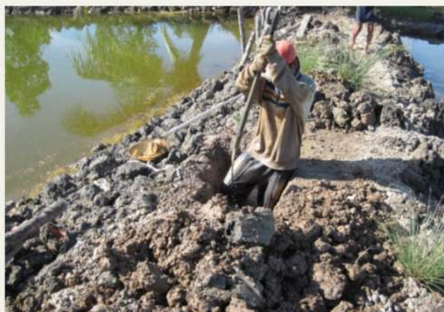
Proses pengambilan tanah dasar, Penambalan pematang perbaikan pematang
