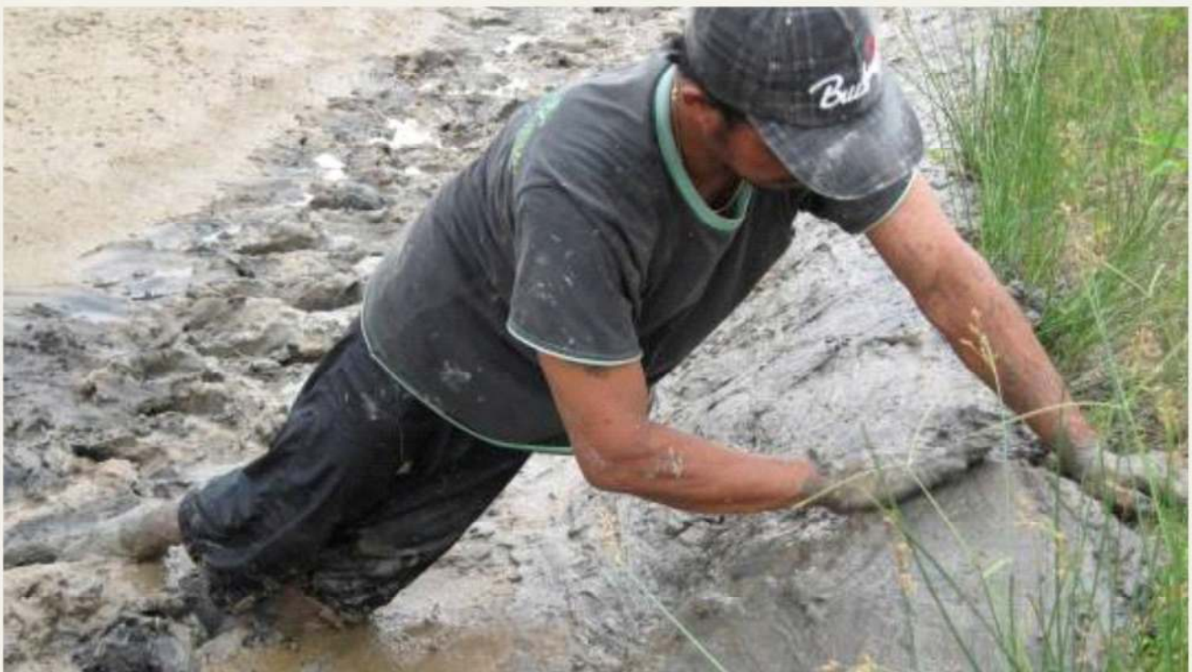
Gb. perbaikan pematang
